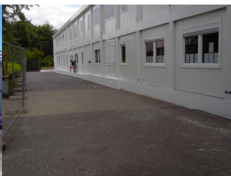
Containeranlage als Interim während der Bauzeit
