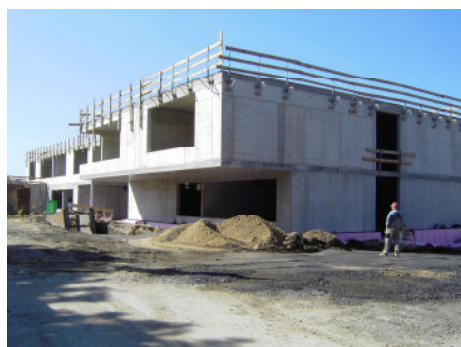
Erweiterungsbau im Robau
