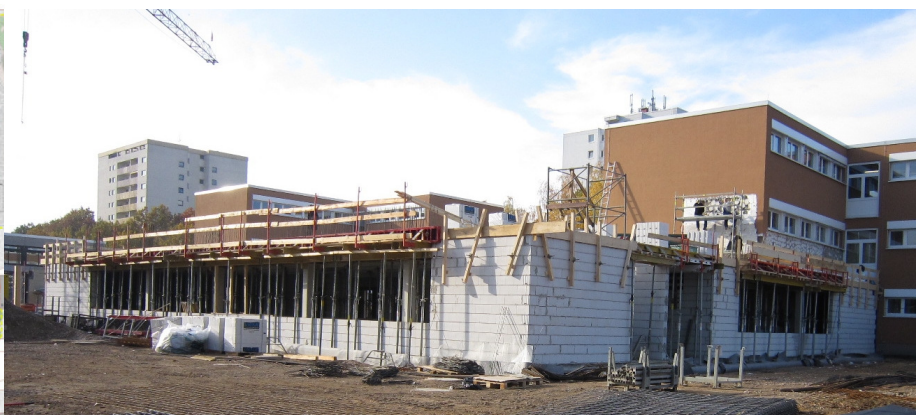
Ersatz- und Erweiterungsneubau im Rohbau
