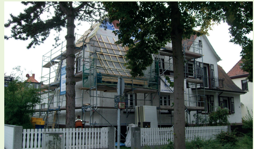
Nach der Energieberatung erfolgt die Sanierung. Haus-zu-Haus Beratung 2012-13
