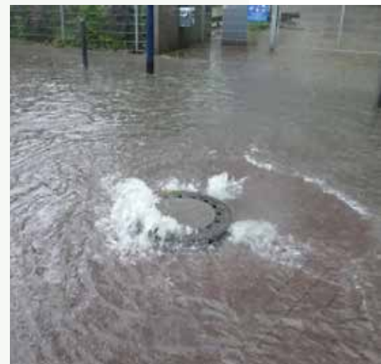
Rückstau aus dem Kanal in der Schloßstraße in Offenbach (Foto S. Justus)
