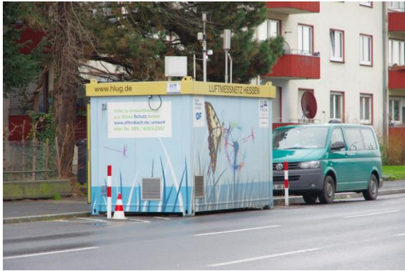
Abb. 8: Verkehrsnahe Luftmessstation Untere Grenzstraße
