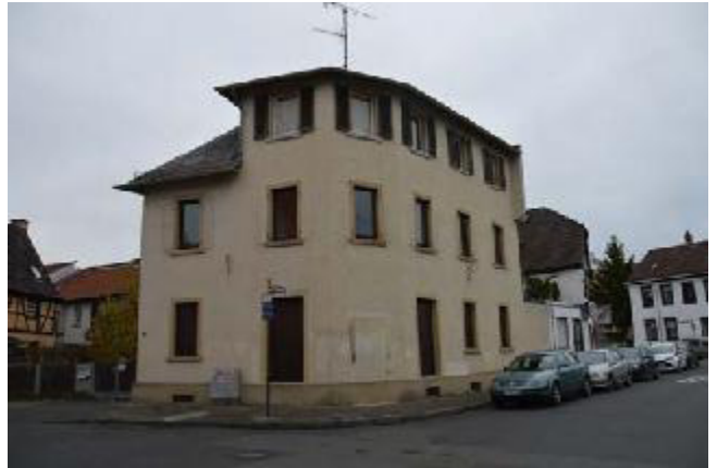
Gebäude mit Leerstand und Sanierungsstau (Fotos: Stadt Offenbach)
