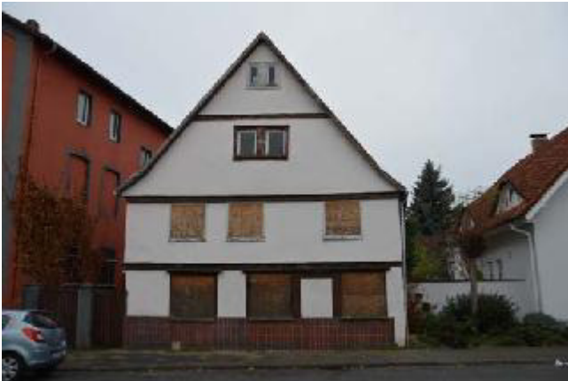
Gebäude mit Leerstand und Sanierungsstau
