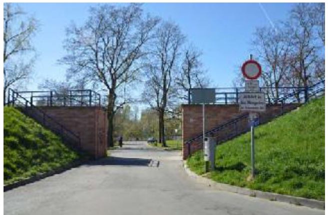
Maindamm Durchgang (Fotos: Stadt Offenbach)
