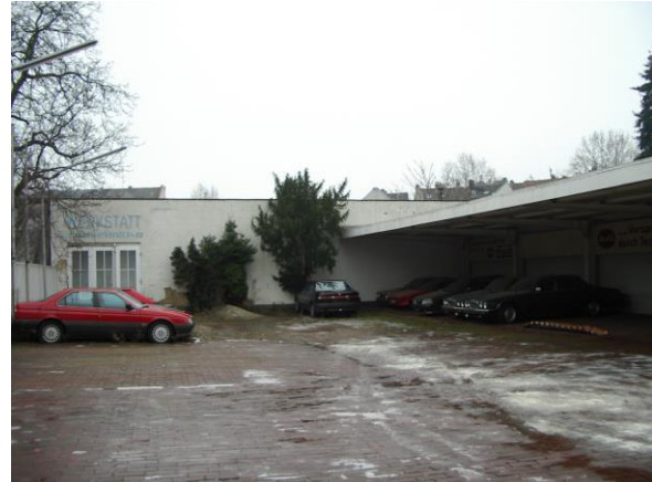
versiegelter Innenhof Bieberer Straße
