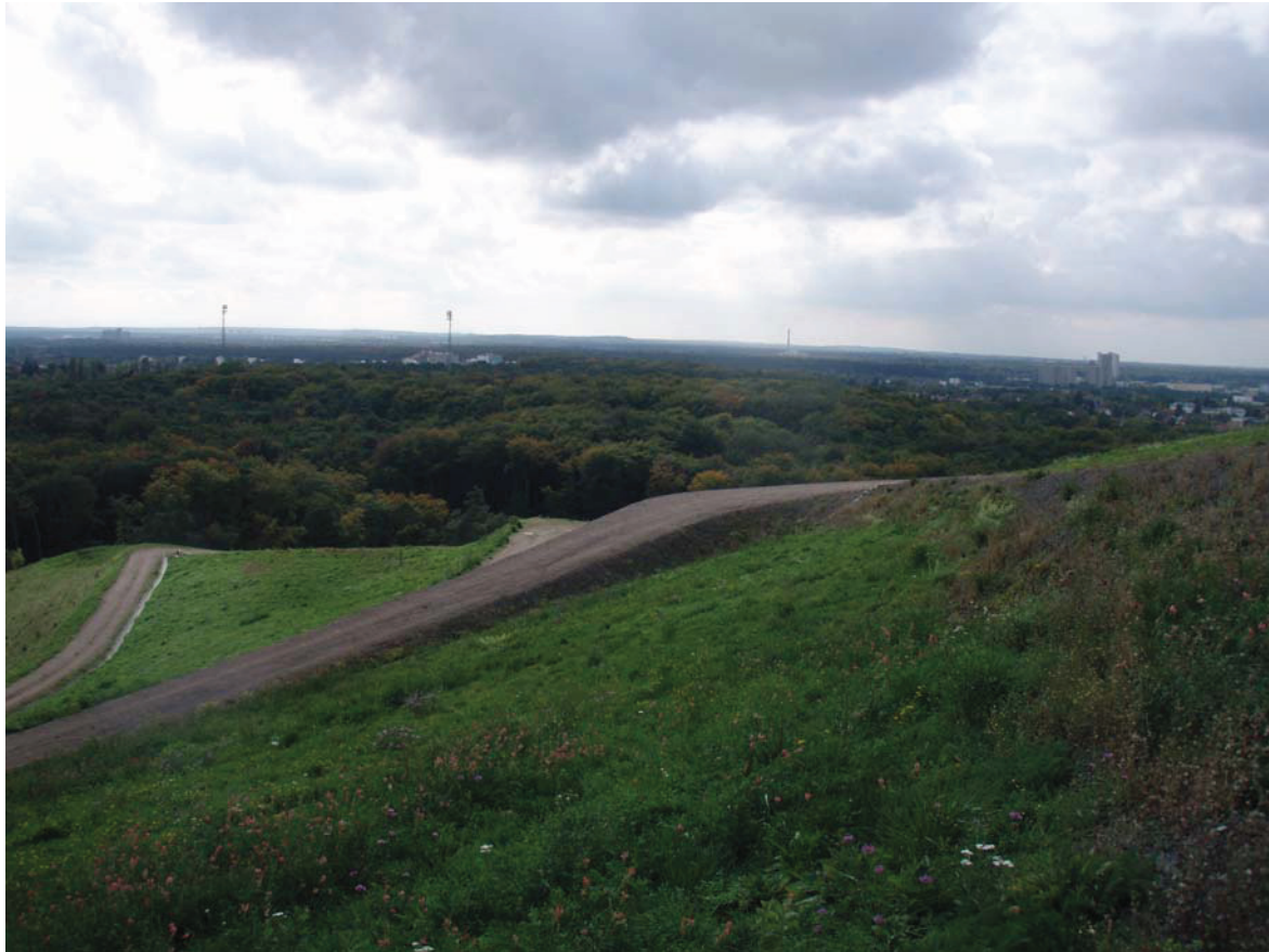
Abbildung 3-2 Blick von der Kuppe des Deponiekörpers in Richtung Süden (Stadion Bieberer Berg) (Foto: Planungsbüro Bierschenk)
