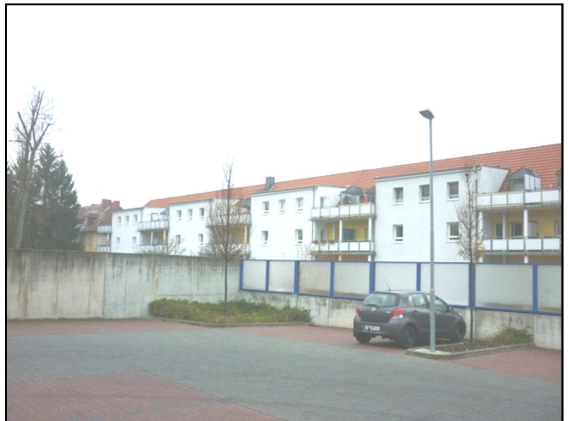
Blick vom Parkplatz nach Westen auf die bestehende Schallschutzwand
