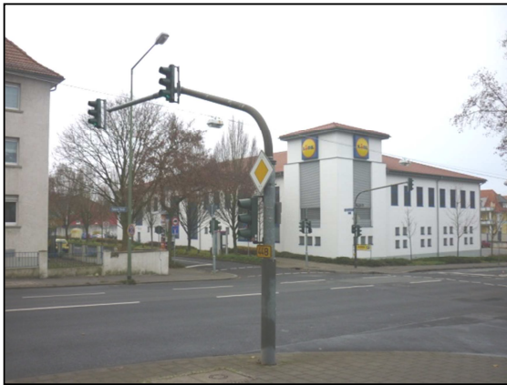
Blick auf die östliche Ecke vom Kreuzungsbereich Bieberer Straße / Kopernikusstraße / Bierbrauerweg
