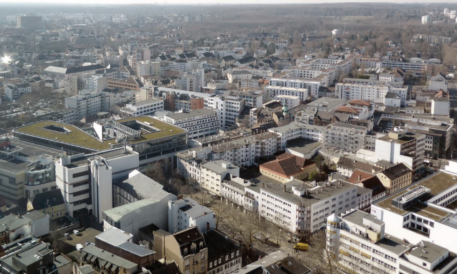
Blick aus dem City-Tower nach Südwesten, Frühjahr 2022
