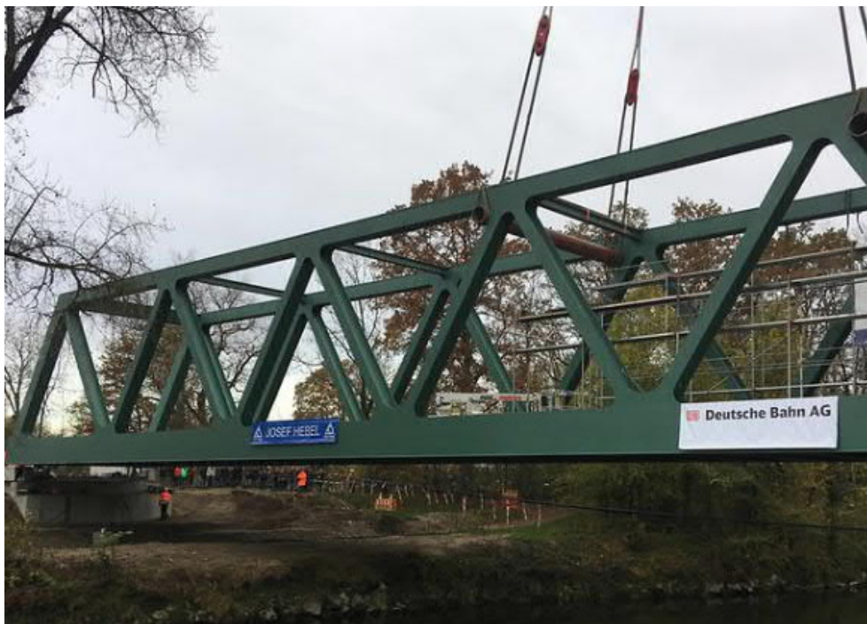
Abbildung 17: Beispiel einer neuen Fachwerkbrücke, Quelle: Deutsche Bahn AG
