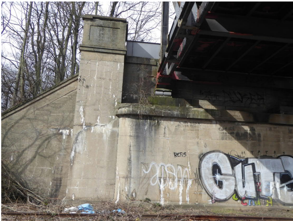
Abbildung 9: Ansicht des nördlichen Widerlagers
