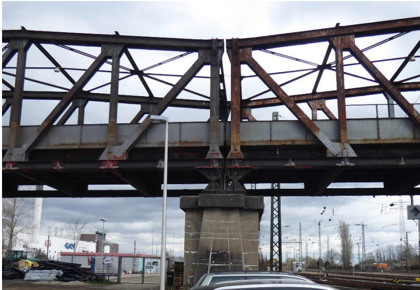
Abbildung 4: Bauwerkszustand im März 2018
