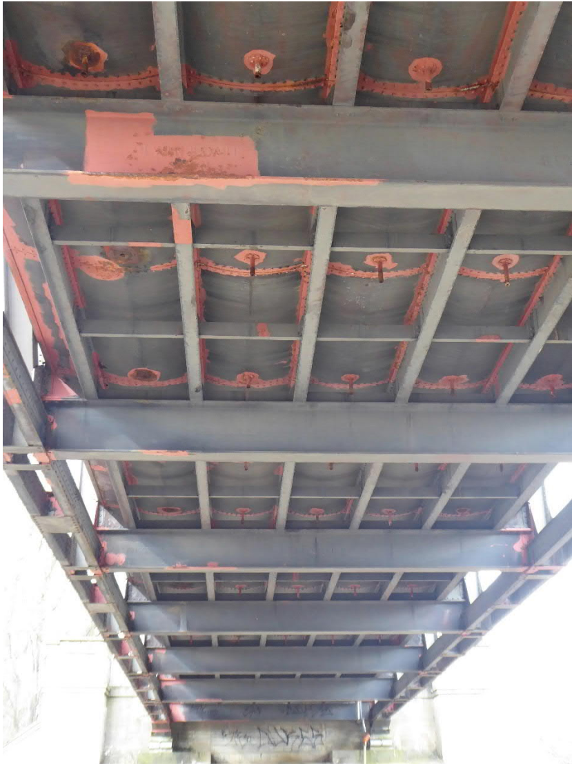
Abbildung 10: Ansicht der Brücke von unten
