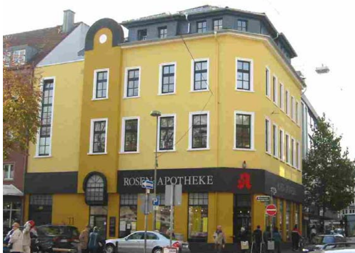
Abb. 14: Renovierte Fassade am Wilhelmsplatz
